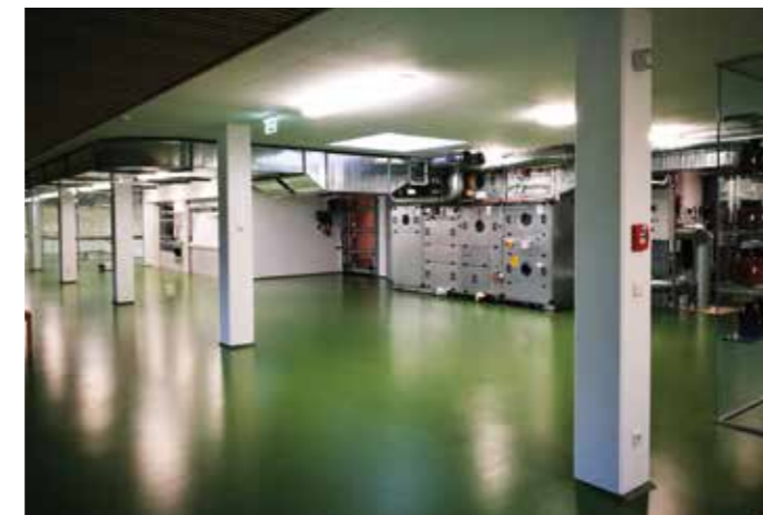
Heizraum Firma Metzler
