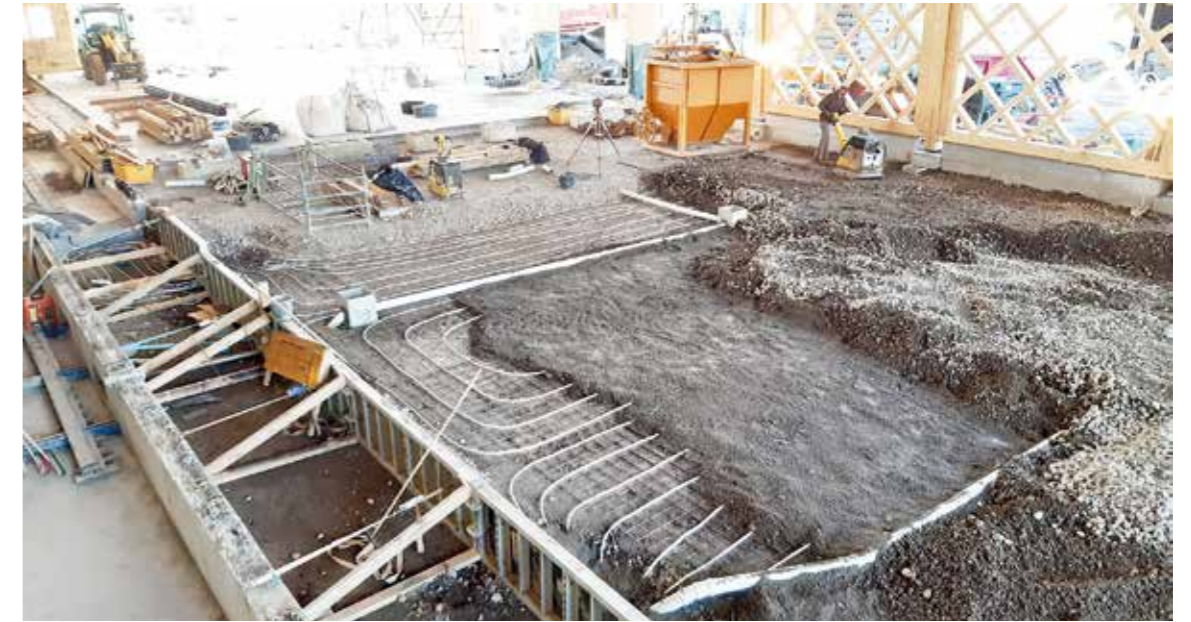
Bauprozess in der bereits aufgerichteten Halle
