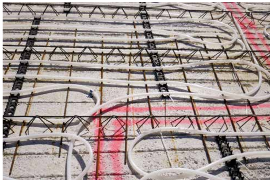
Verlegung Bauteilaktivierung
