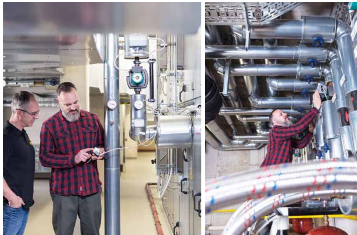
Kontrolle und Optimierung Anlagentechnik
